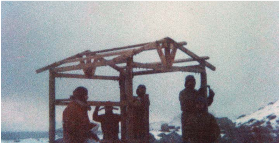
Foto 1: Refugio en construcción (foto de Juan Vázquez, 1985)
