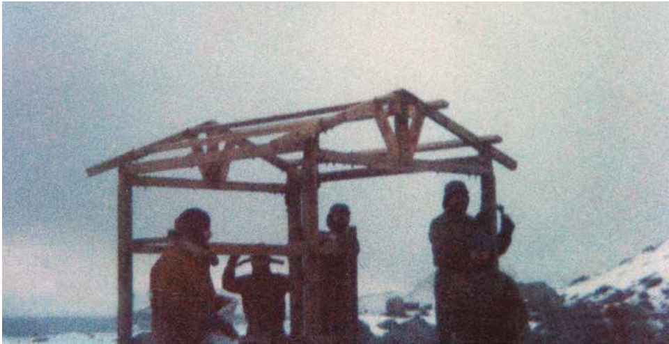
Foto 1: Refugio en construcción (foto de Juan Vázquez, 1985)
