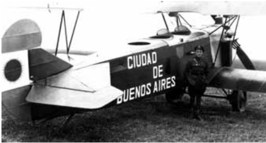
Zanni junto al avión para la primera etapa (terrestre), nótese la modificación de la tercera cabina y los radiadores de aceite a los costados del motor. Foto: A.G.N.
