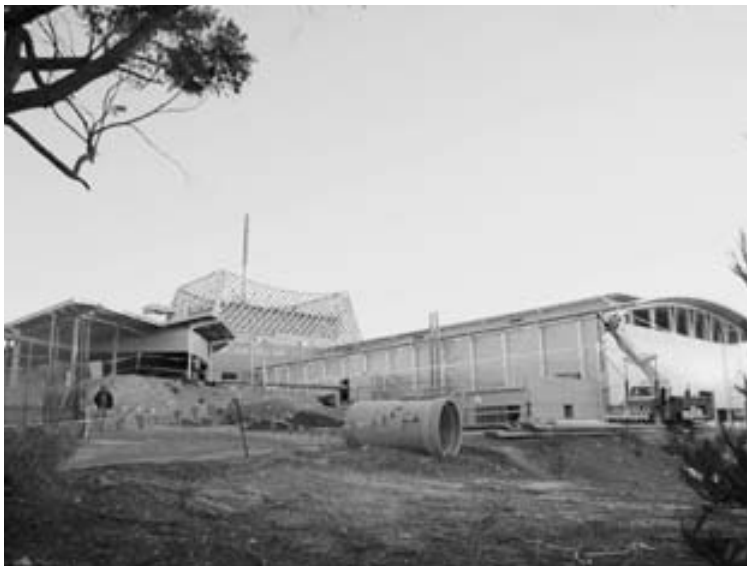
Construcción del edificio contenedor del reactor nuclear.
