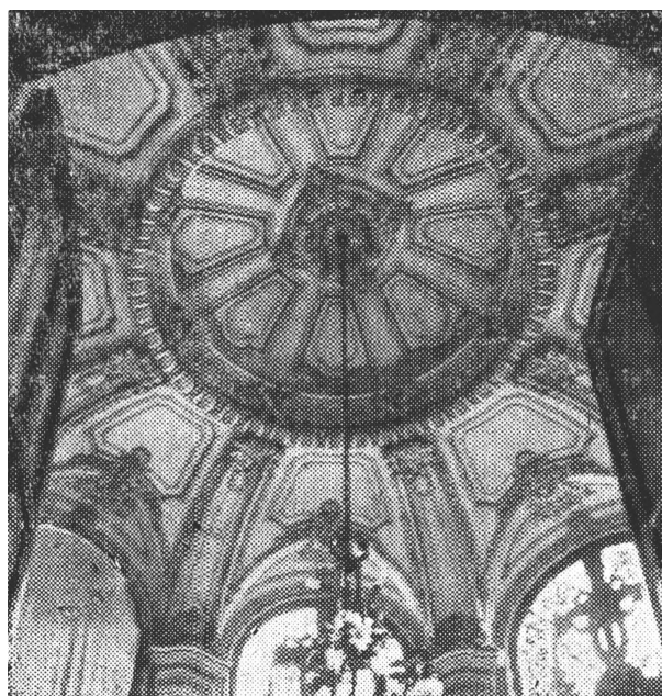
Ornamentos de una parte del cieloraso del Salón de Actos del 2º piso
